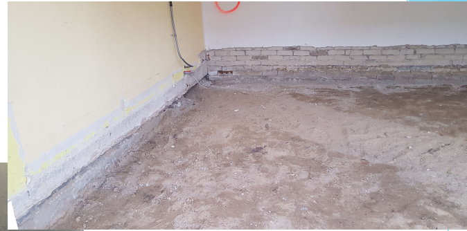
Fußboden bis auf den gewachsenen Boden abgetragen
