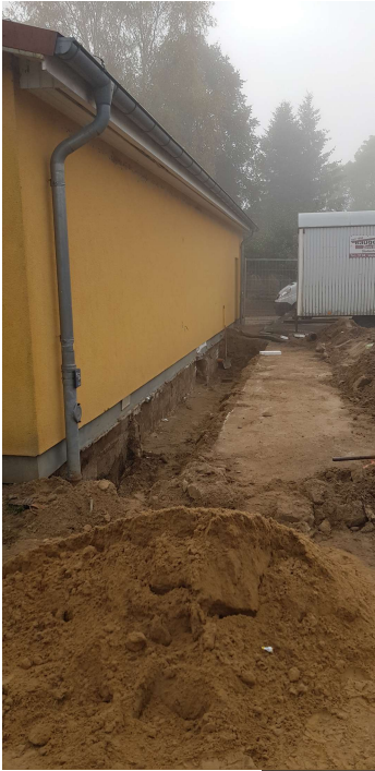
Fundament trocken gelegt
