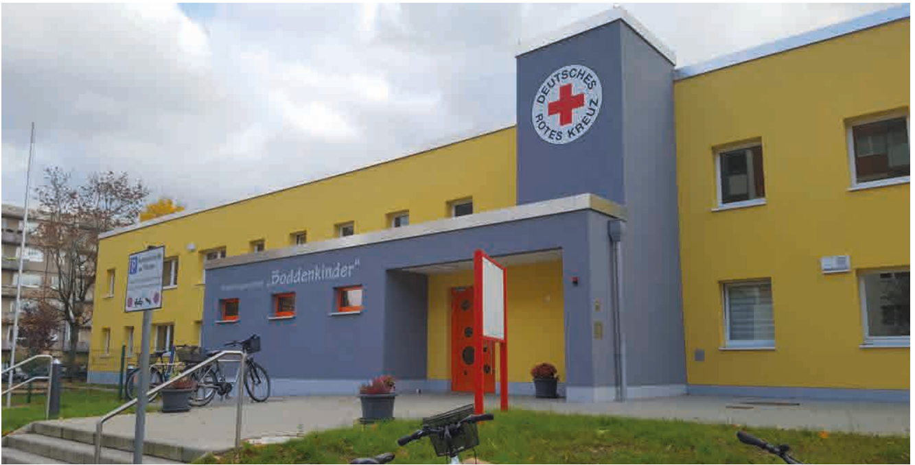
Der neue Name der Kita zielt den Eingangsbereich der sanierten und neu gestalteten Einrichtung.
